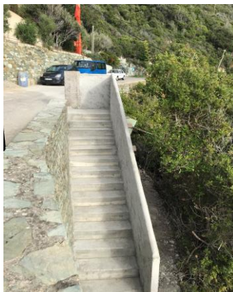
Escaliers marine de Cannelle
