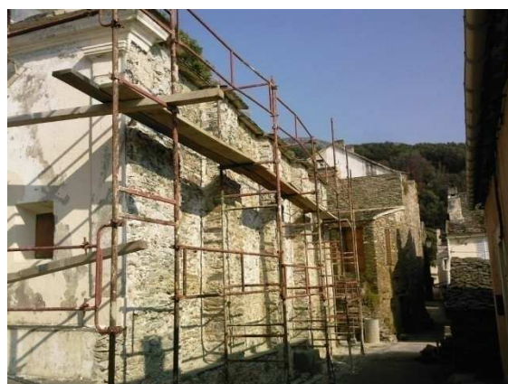
Figure 9 : Travaux de la Chapelle de l'Annonciation ( Façade ouest) (Photo Nathalie CHIARAMONTI)
